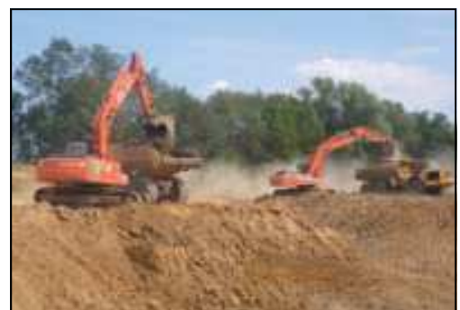
Travaux de définition du tracé du nouveau lit et travaux de terrassements. (Source SMVV)
