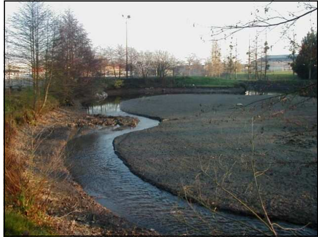
Le site du plan d'eau de la Motte après restauration. (Source SIABVS)
