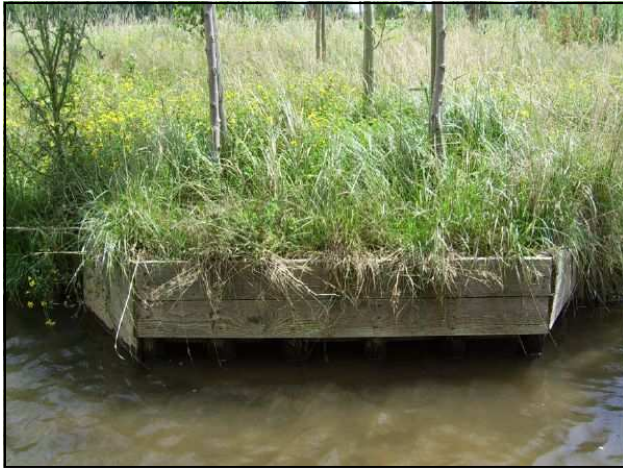
Exemple d'aménagements réalisés sur le Rule. Une sous-berge par caisson végétalisé et un seuil de fond. (Source F. Pierron)
