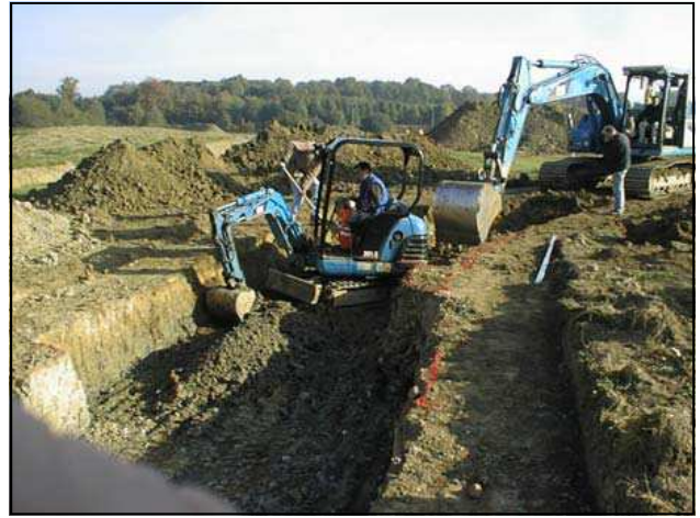
Travaux de creusement du nouveau chenal. (Source F. Pierron)
