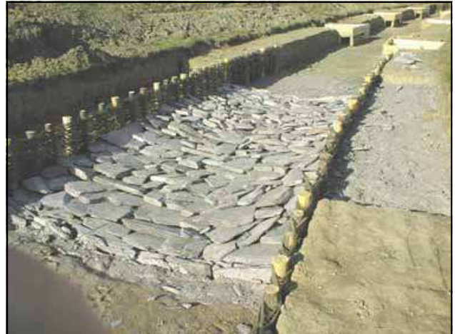
Exemple d'aménagements réalisés sur le Rule. Une sous-berge par caisson végétalisé et un seuil de fond. (Source F. Pierron)
