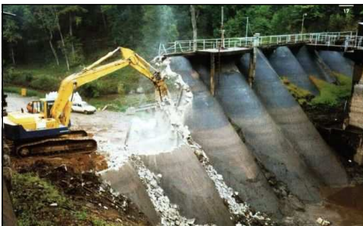
Travaux d'arasement du barrage de Kernansquillec. (Source Association Vallée du Léguer)
