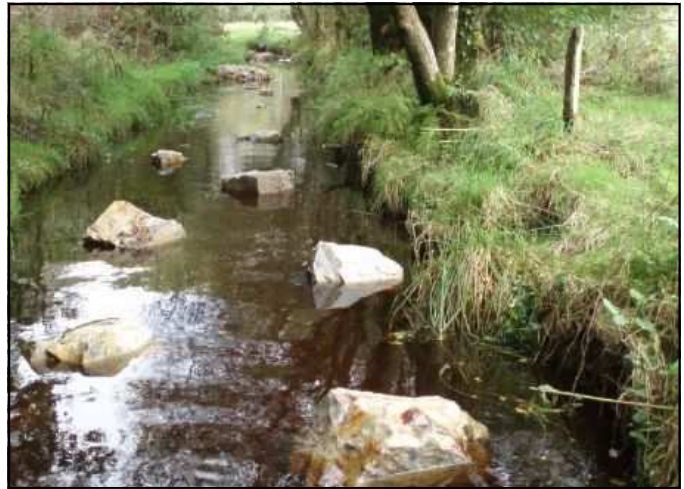
Blocs installés dans le lit du Langonnet. (Source Y. Fuentes –FDPPMA56)
