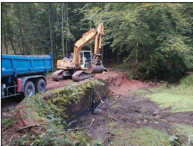
Suppression d'un ouvrage de vidange. (Source ONEMA SD57)
