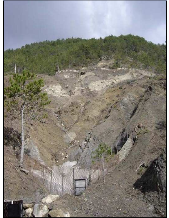
Une ravine d'Ausson après les travaux de déboisement.
