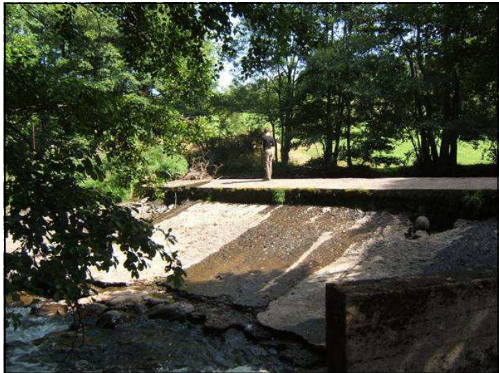
Le seuil de Stalapos avant arasement. (Source SIGAL)
