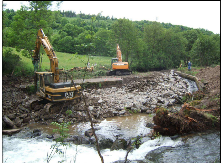
Travaux d'arasement du seuil de Stalapos en juin 2008. (Source SIGAL)
